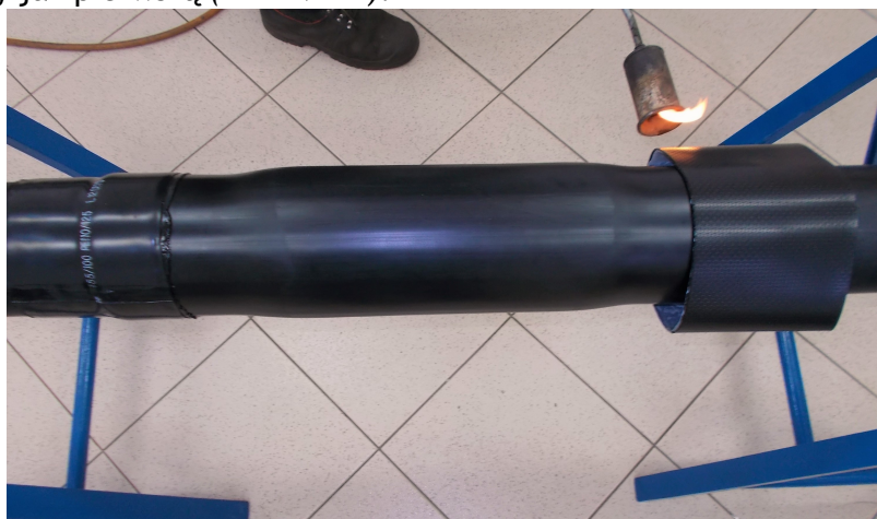
Fot. Nr 44 Obkurczenie opaski termokurczliwej znajdującej się po drugiej stronie nasuwki.
