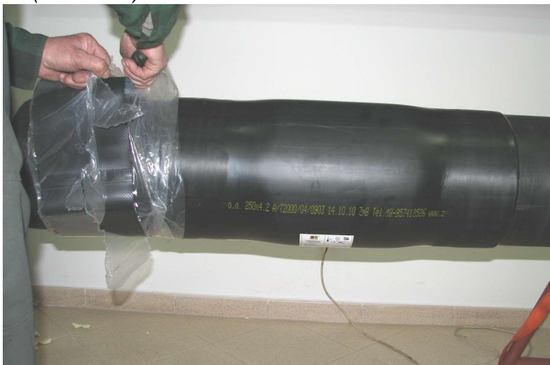
Fot. Nr 38 Umieszczenie opasek termokurczliwych w miejsce ich montażu oraz usunięcie z nich folii zabezpieczającej przed zabrudzeniem.
