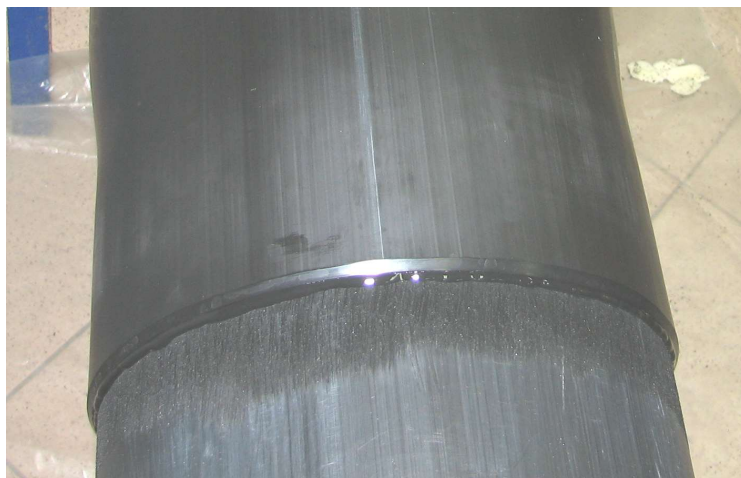
Fot. Nr 32 Widok wypływu spoiwa kleju na krawędzi nasuwki termokurczliwej – obwodzie rury preizolowanej.
