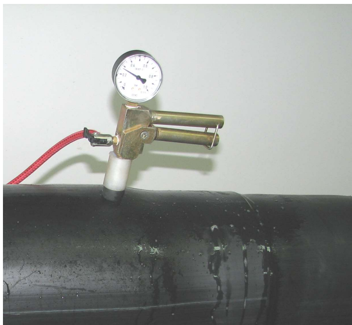
Fot. Nr 35 Wypełnienie złącza powietrzem.
