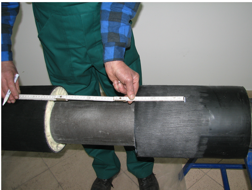
Fot. Nr 25 Oznaczenie obliczonych wymiarów przy wyznaczeniu położenia krawędzi nasuwki termokurczliwej
