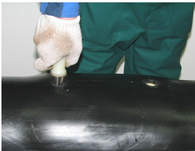
Fot. Nr 55 Ukosowanie krawędzi otworów wlewowych przy pomocy ręcznego frezu stożkowego.
