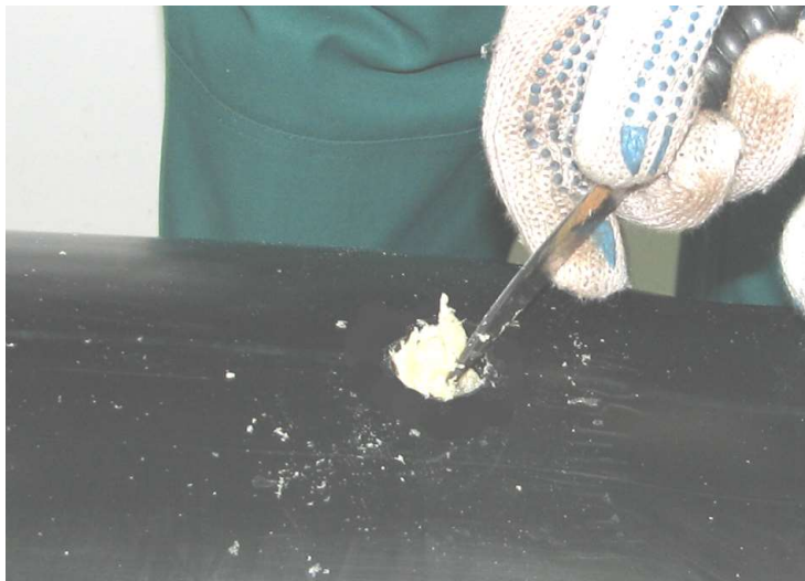
Fot. Nr 54 Usunięcie pianki PUR z otworów wlewowych na głębokość ok. 5mm.
