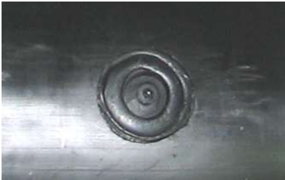
Fot. Nr 60 Widok prawidłowo zamontowanego korka wgrzewanego.
