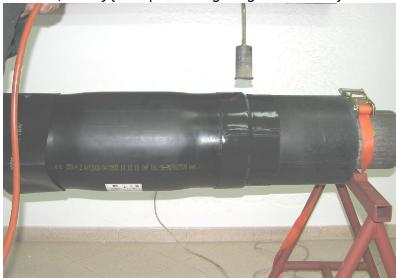
Fot. Nr 43 Obkurczenie opaski termokurczliwej po stronie rury osłonowej.
