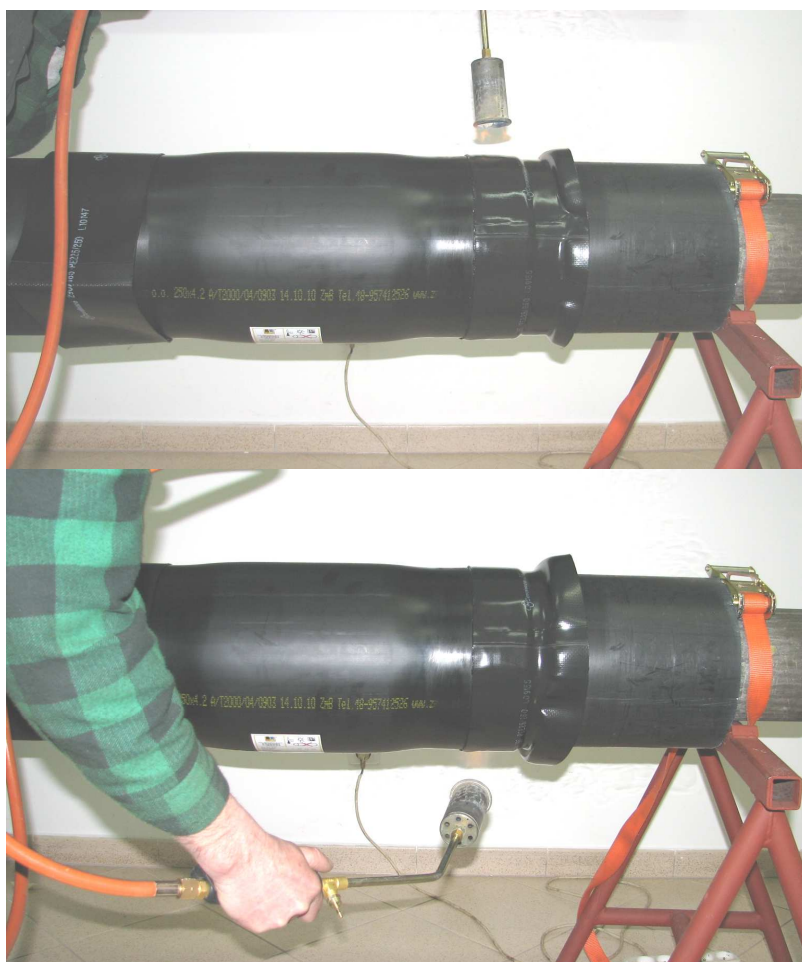
Fot. Nr 41 i 42 Obkurczenie opaski termokurczliwej po stronie nasuwki.
