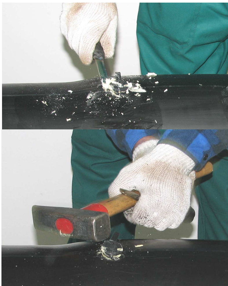
Fot. Nr 52 i 53 Usunięcie korków odpowietrzających z otworów wlewowych.
