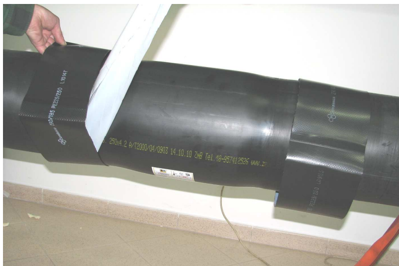
Fot. Nr 40 Usunięcie taśmy zabezpieczającej przed zabrudzeniem z wewnętrznej powierzchni opasek termokurczliwych.
