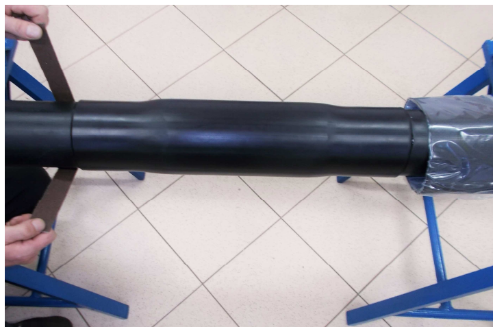
Fot. Nr 36 Ręczne czyszczenie za pomocą papieru ściernego o ziarnistości 50 + 70 powierzchni rur osłonowych elementu preizolowanego oraz nasuwki termokurczliwej – miejsc montażu opasek termokurczliwych.
