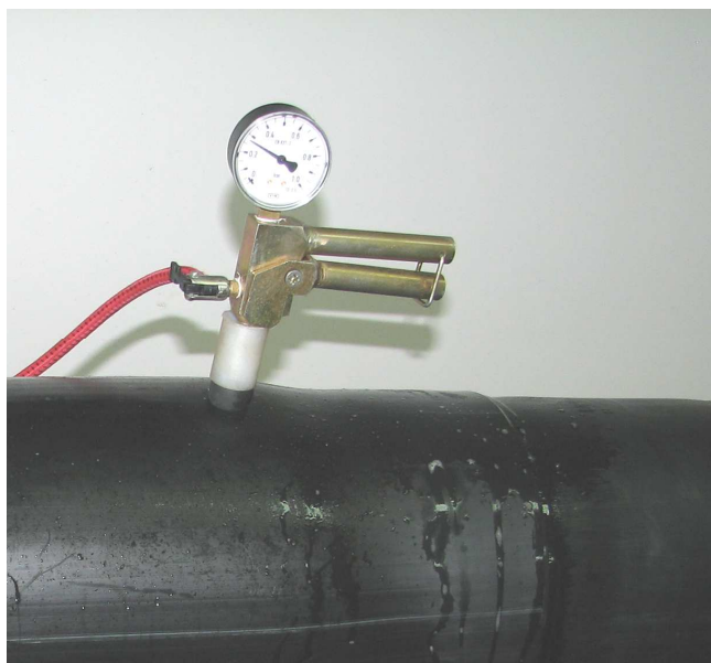
Fot. Nr 35 Wypełnienie złącza powietrzem.
