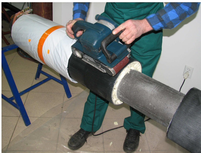
Fot. Nr 23 Czyszczenie rury osłonowej elementu preizolowanego za pomocą szlifierki taśmowej z papierem ściernym o ziarnistości 50 + 70
