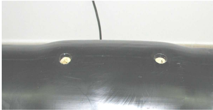
Fot. Nr 56 Oczyszczenie otworów wlewowych miejsca montażu korków wgrzewanych.
