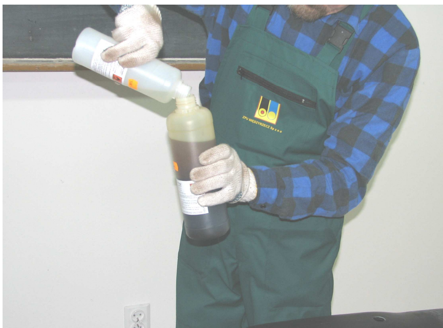
Fot. Nr 47 Przelanie składnika A do butelki ze składnikiem B pianki PUR.
