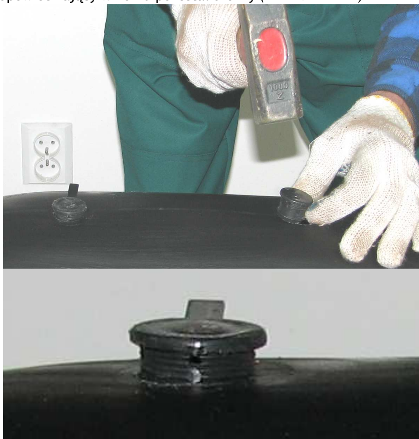
Fot. Nr 50 i 51 Osadzenie korków odpowietrzających w otworach wlewowych.
