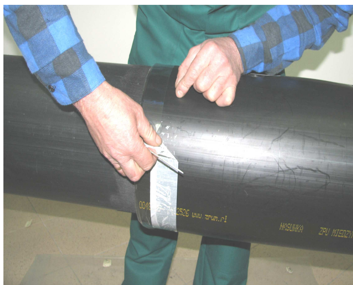
Fot. Nr 27 Zdjęcie wewnętrznej folii zabezpieczającej klej w nasuwce termokurczliwej.
