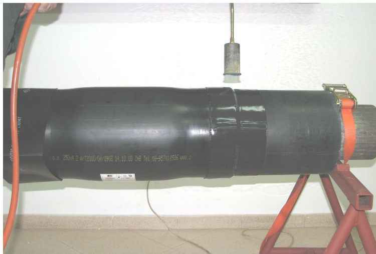
Fot. Nr 43 Obkurczenie opaski termokurczliwej po stronie rury ostonowej.
