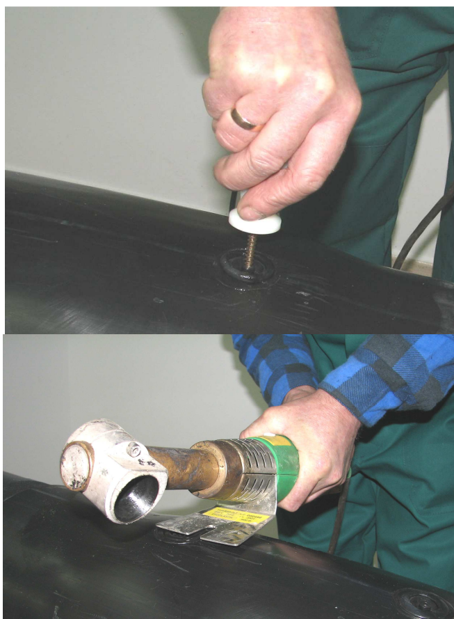
Fot. Nr 58 i 59 Umieszczenie podgrzanego korka w otworze wlewowym złącza.
