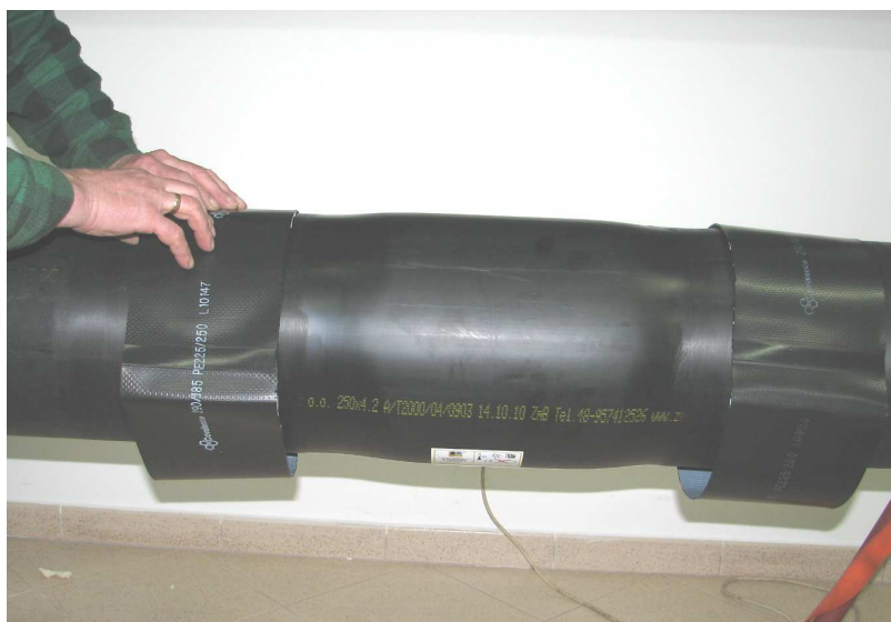
Fot. Nr 39 Umieszczenie opasek termokurczliwych centralnie na krawędzi nasuwki termokurczliwej.
