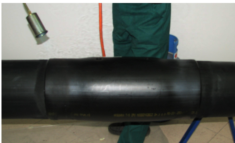
Fot. Nr 37 Podgrzanie oczyszczonej nasuwki i rury osłonowej do temperatury około 40 °C
