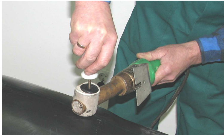
Fot. Nr 57 Podgrzanie do stanu uplastycznienia zewnętrznej krawędzi otworu wlewowego i powierzchni stożkowej korka przy pomocy zgrzewarki do korków.
