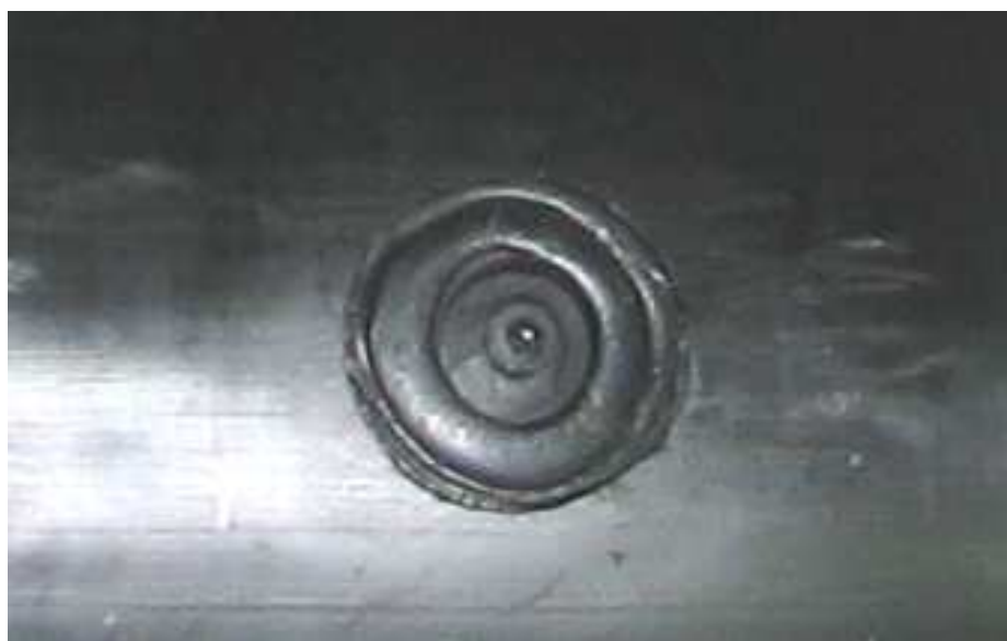
Fot. Nr 60 Widok prawidłowo zamontowanego korka wgrzewanego.
