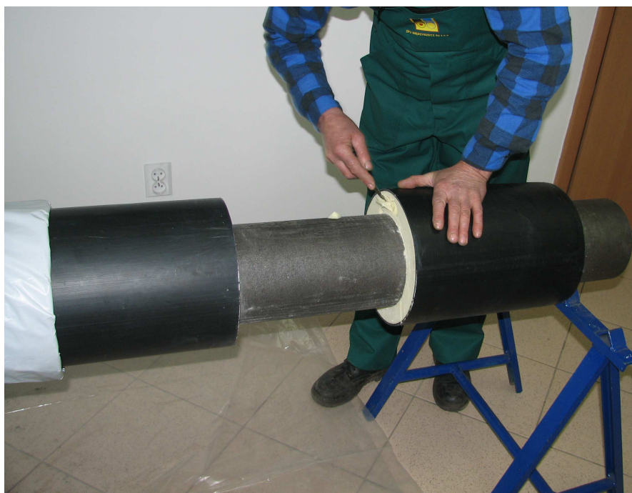
Fot. Nr 22 Usunięcie przy pomocy noża lub skrobaka, części izolacji termicznej – pianki PUR o gr. do 15 mm z czoła łączonych elementów preizolowanych.
