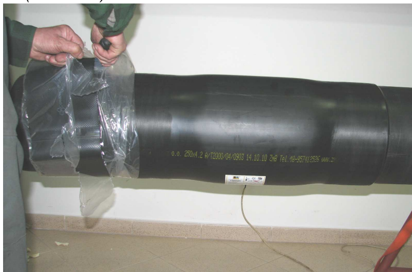
Fot. Nr 38 Umieszczenie opasek termokurczliwych w miejscu ich montażu oraz usunięcie z nich folii zabezpieczającej przed zabrudzeniem.
