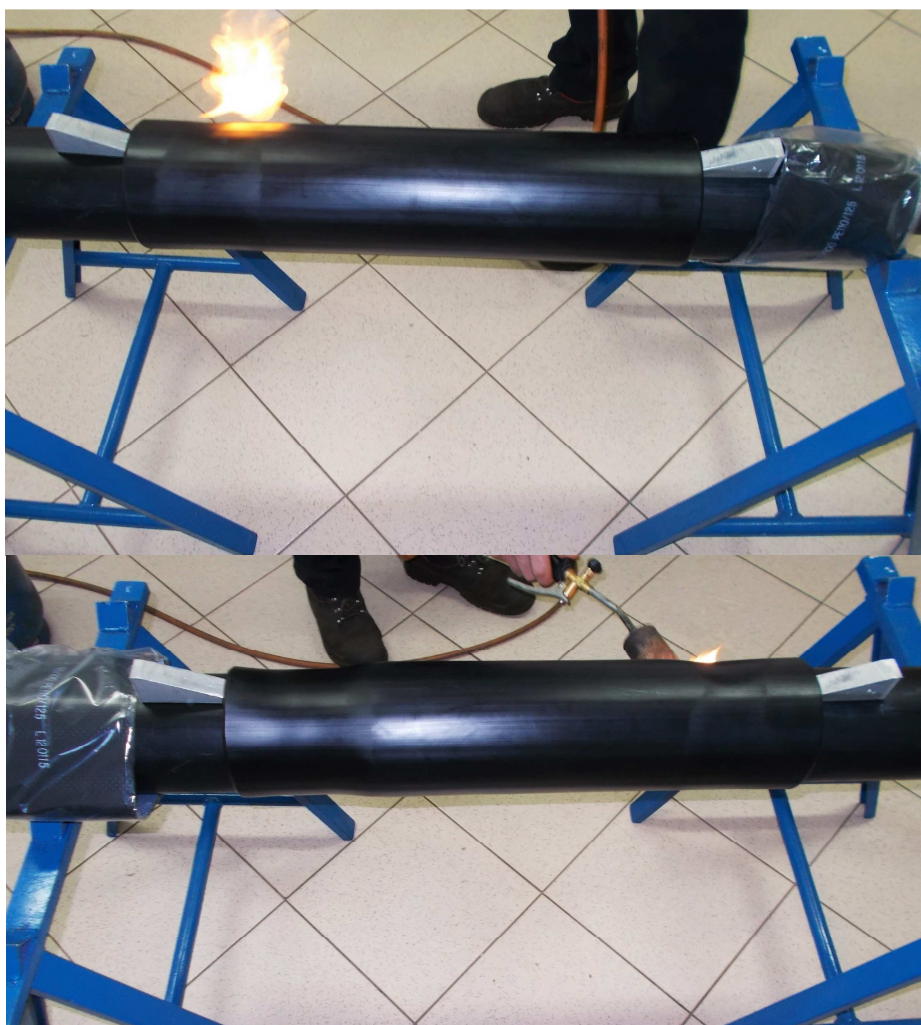
Fot. Nr 29 i 30 Obkurczenie końców nasuwki termokurczliwej „miękkim” płomieniem palnika na płynny gaz propan – butan.
