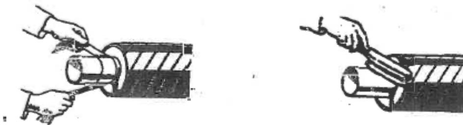
Przygotowanie powierzchni rury przewodowej i osłonowej przed nałożeniem rękawa termokurczliwego.
